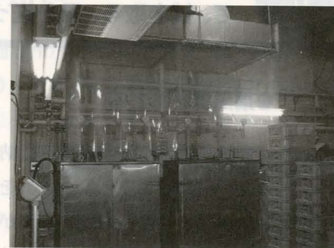
ダクトからスチーマーまでビニールカーテンを下げ、蒸気拡散防止
